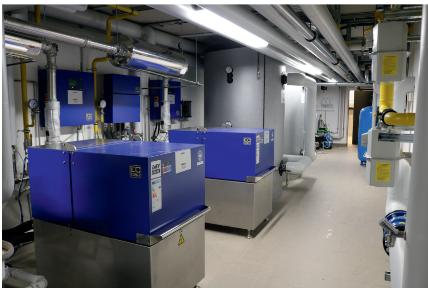
Blockheizkraftwerk
